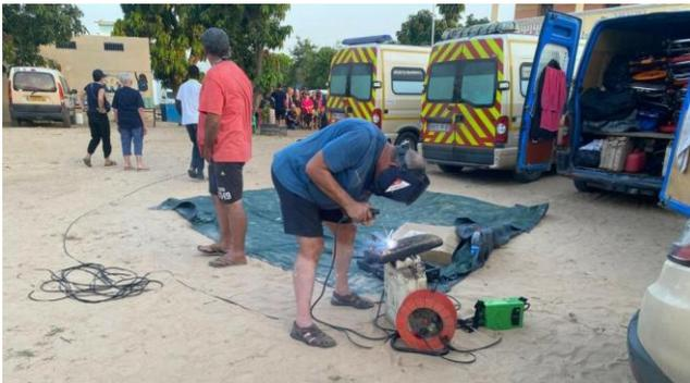
Même sous une température caniculaire, rien ne les arrête. Ici, préparation du support pour intégrer un brancard dans l'un des véhicules qui sera livré demain.
